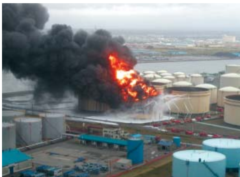
タンク火災の消火の様様
